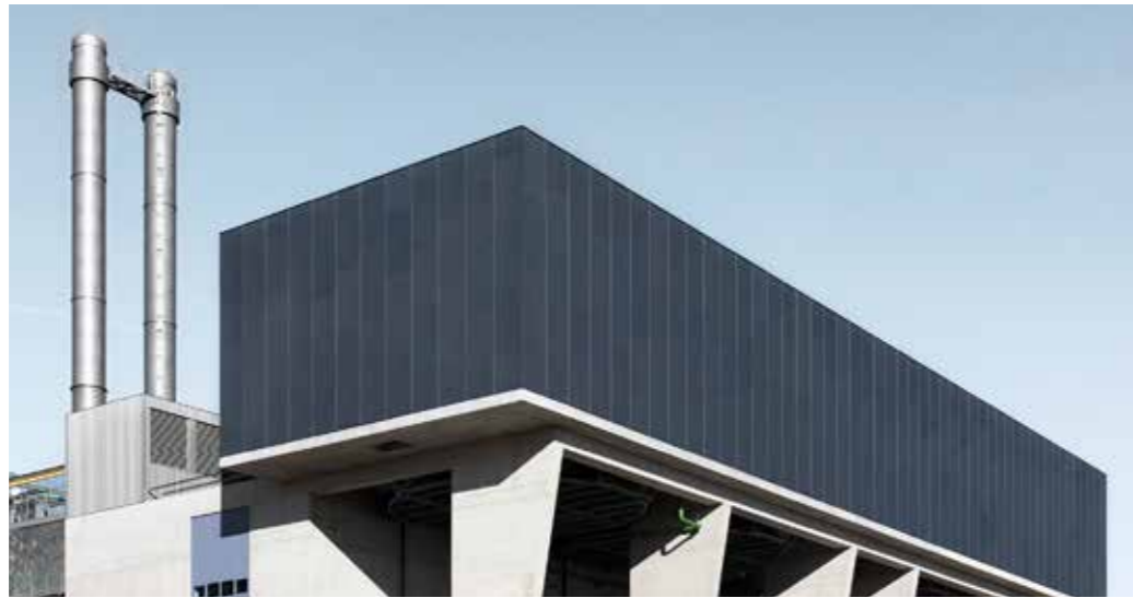
Kehrichtverwertung Stadtwerk Winterthur
